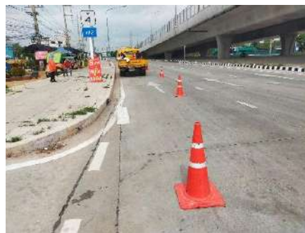
ภาพที่ 5.2-1 ตัวอย่างการตั้งกรวยก่อนถึงบริเวณที่มีการปิดช่องจราจร
