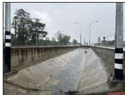
รางระบายน้ำดาดคอนกรีตเกาะกลางถนน
